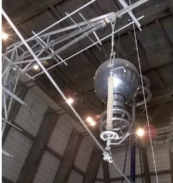
Şekil 26; 170 kV Elektriksel Test Düzeneği
