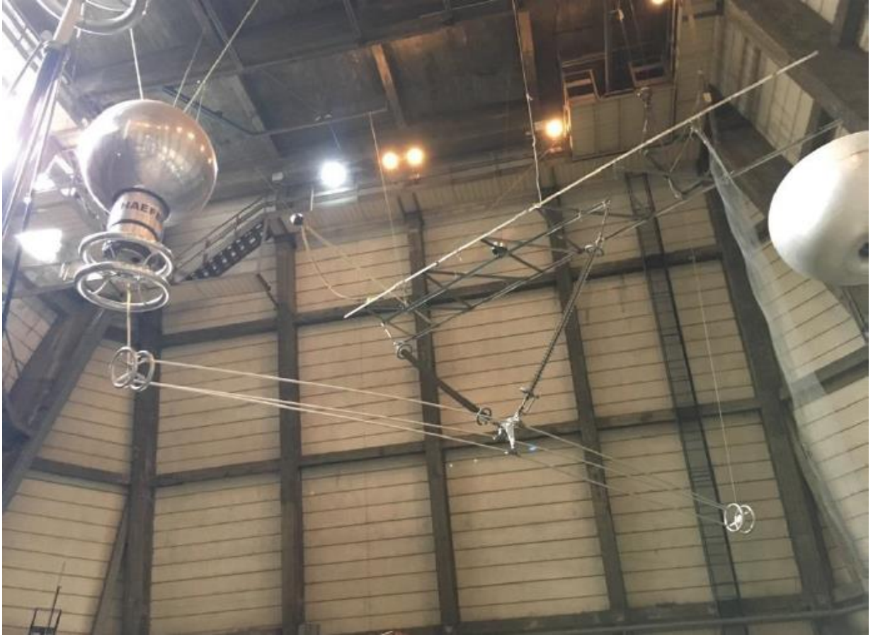
Şekil 28; 420 kV, V Askı İzolatö Takımı için Test Düzeneği
