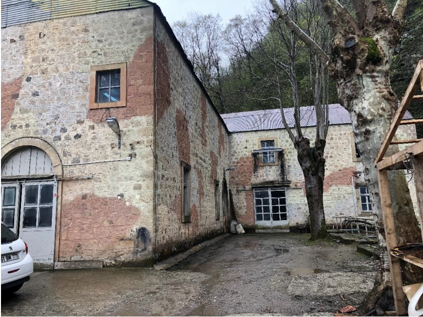
Santrali Günümüz Görünüşü
