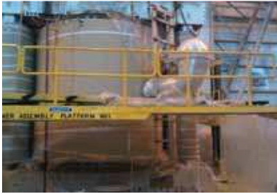
Şekil 14. 1200 kV sargı çıkış grubunun trafo sargısına montajı
